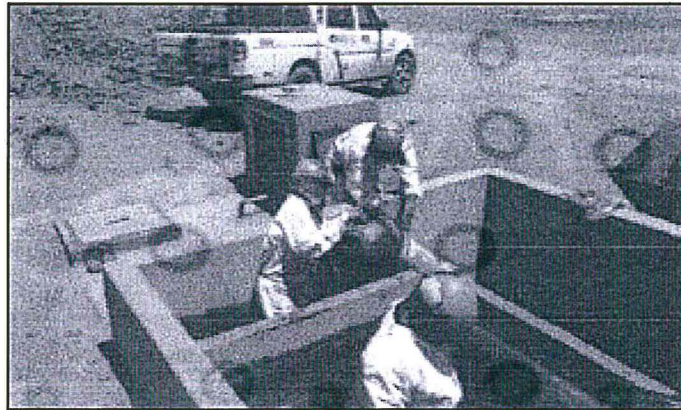
"Implementación de una rejilla en el ducto de ingreso al tanque de almacenamiento" Fuente: Shougang (Anexo 3.3 del Escrito con Registro N° 2016-E01-001882)
