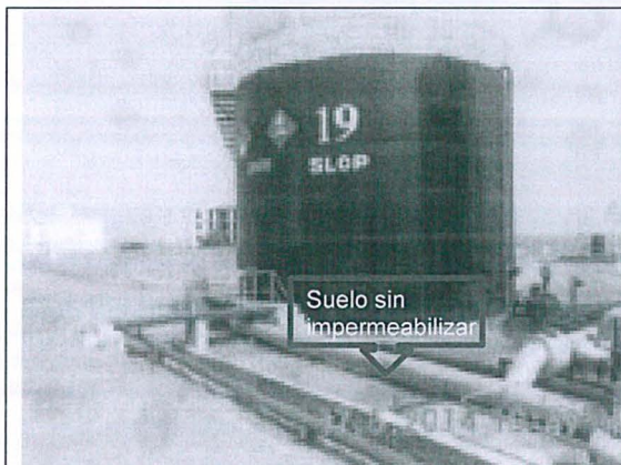
Registro Fotográfico N° 5. En la imagen se observa, el tanque 19 (slop), donde el área estanca de la base está conformada con suelo natural (sin impermeabilización) – terminal Ilo.
