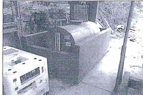
Después de los trabajos.
