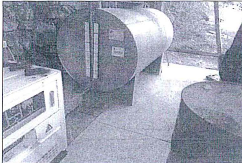
Antes de los trabajos.
