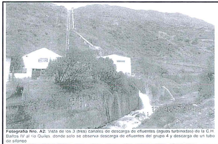
Vista fotográfica N° A2 del Informe de Supervisión
