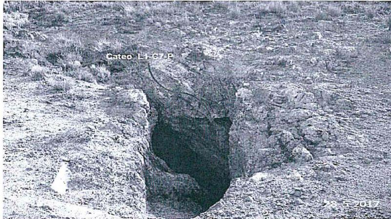
Fotografía N° 74: Vista del cateo L1-C7-P, ubicado en las coordenadas UTM (WGS 84), E: 223735 N: 8 923443, este componente se encuentra abierto, no se ha realizado el relleno, ni la cobertura, por un sector se observa vegetación propia de la zona.
