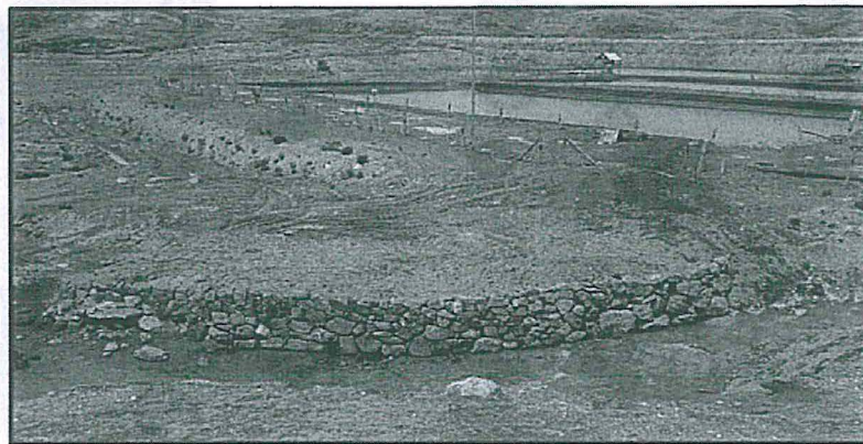
FotoN04: Vista final del muro pilcado donde se observa que no hay descargas de agua hacia el canal lateral.
