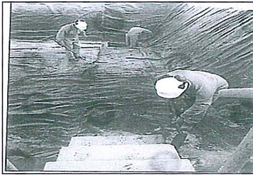
Foto 1. Limpieza de geomembrana en las Pozas.
