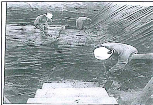
Foto 1. Limpieza de geomembrana en las Pozas.
