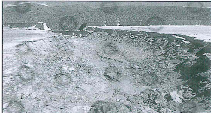
Fotografía N° 95. Hallazgo N° 04.- Se observa la zona de la cual se desplazó el relave, el volumen aproximado de relave derramado es de 2000 m 3
