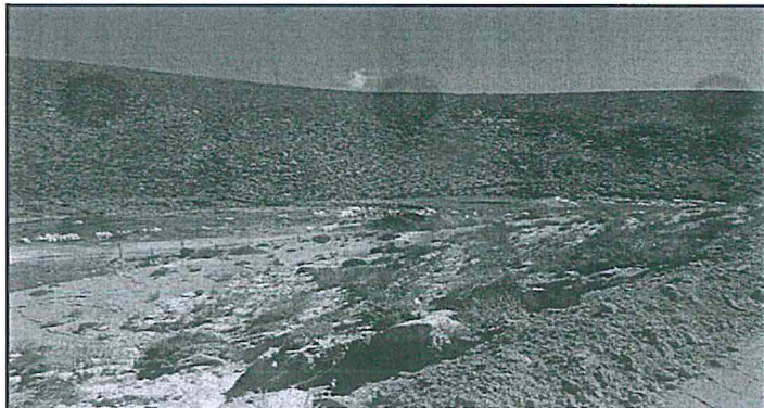
Fotografía N° 97. Hallazgo N° 04.- Vista de la banqueta, el relave se ha depositado directamente en el suelo, zona ubicada en la parte baja del depósito de relaves N° 4.
