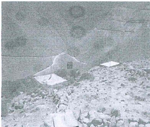
Fotografía N°5: Re-direccionamiento de la línea principal del ARD al pozo séptico N°3 para captación y actual funcionamiento.
