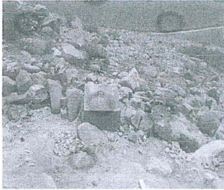
Fotografía N°4: Implementación de cajas de registro y conexiones a la línea principal del ARD.
