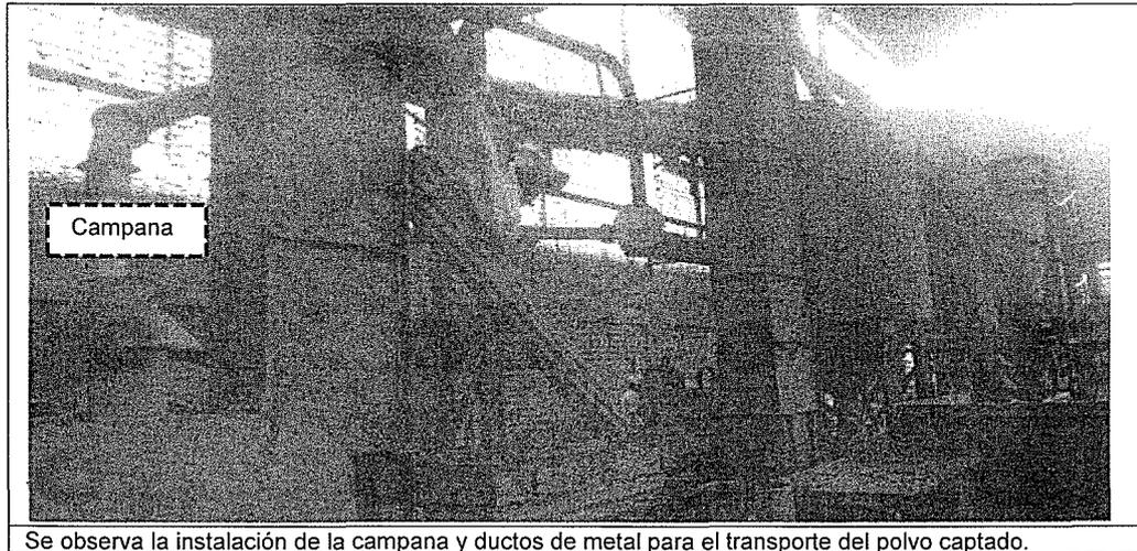
34. Del análisis de las fotografías, se advierte que Fundición Callao instaló un sistema colector de polvos constituido por campanas extractoras, ductos de metal, ciclón y ventilador, todos estos equipos instalados en la Zona de Fusión (Nave de Fundición) de la Planta Callao, a fin de evitar la emisión de polvos.
