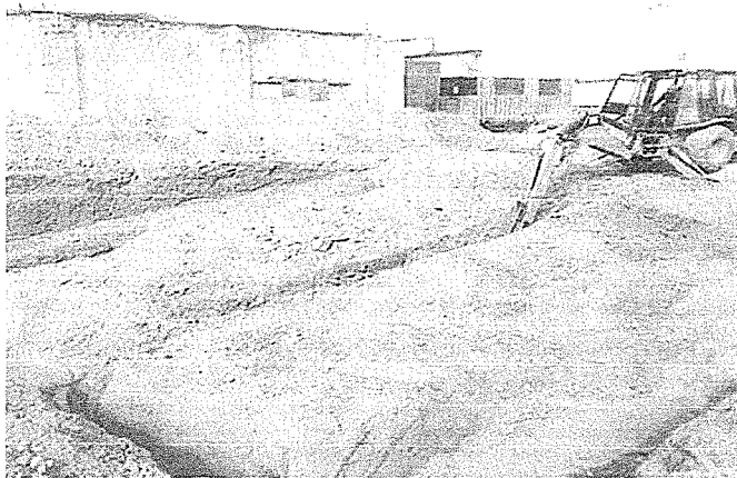
Excavación de zanja
