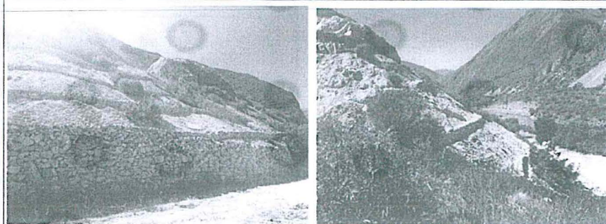
Estabilidad y construcción de bancos con mampostería.
