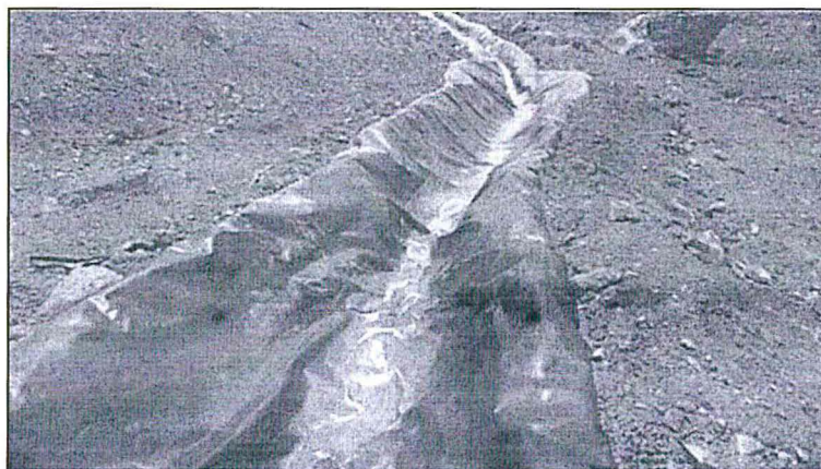
FOTO N° 10: Impermeabilización del sistema de tratamiento ST-05
