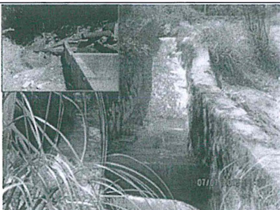
FOTOGRAFÍA N° 18: HALLAZGO N° 6 Canal de captación de agua de mina, en la parte superior izquierda se observa una tubería de 6" que no tiene la misma capacidad del canal.
