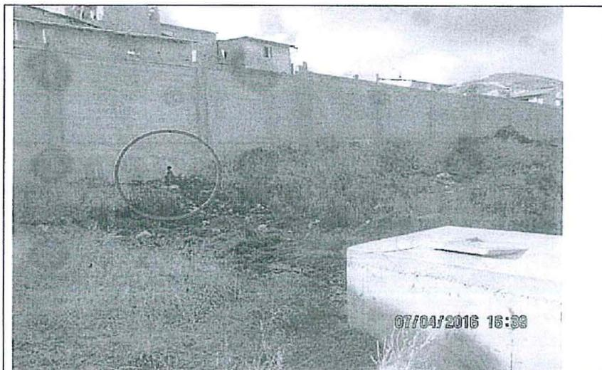
Fotografía N° 8. Hallazgo N° 01.- Vista de caja de registro de aguas residuales (sin presencia de aguas), próxima a muro perimetral y colindante con la Población de José Carlos Mariátegui. En el muro se aprecia una perforación por donde se drenan aguas residuales de la población hacia la zona de stock piles de coordenadas WGS 84 Zona 18 E: 360911 N: 8819786
