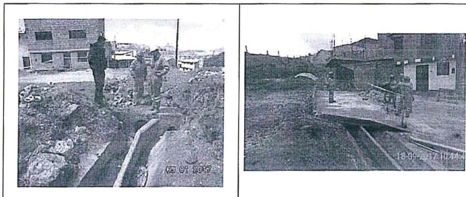
Fotografías Nro.3 y Nro.4.- Canal de concreto, de doble compartimiento totalmente refaccionado.
