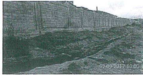
**Fotografías Nro.1 y Nro.2.-** Canal de geomembrana para colectar las aguas residuales de origen poblacional que drenan a través de perforaciones en el muro de concreto en la zona de José Carlos Mariátegui.
