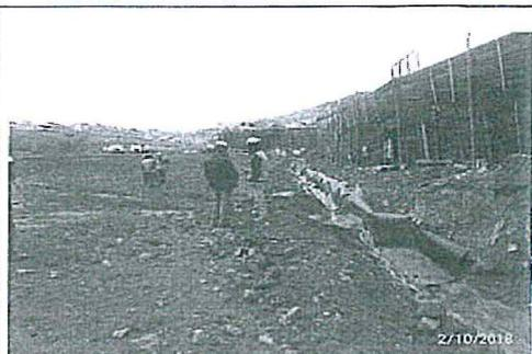
**Fotografías Nro.5 y Nro.6.-** Retiro de material del área cercana a la población. Se ha eliminado los encharcamientos en el área, el canal revestido con geomembrana drena las aguas de contacto hacia el canal colector principal (ver fotografía Nro. 7 y 8)
