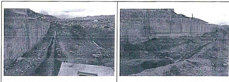
Fotografías Nro.1 y Nro.2.- Canal de geomembrana para colectar las aguas residuales de origen poblacional que drenan a través de perforaciones en el muro de concreto en la zona de José Carlos Mariátegui.
