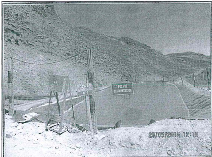
Fotografía N° 12: Poza de sedimentación N° 1, se encuentra revestida también con geomembrana.
