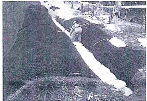
Registro fotográfico que evidencia la protección del talud con geomanta MacMatR y Geotextil REPAV 450 en el talud del kp 41+550 (15 de octubre del 2017)
