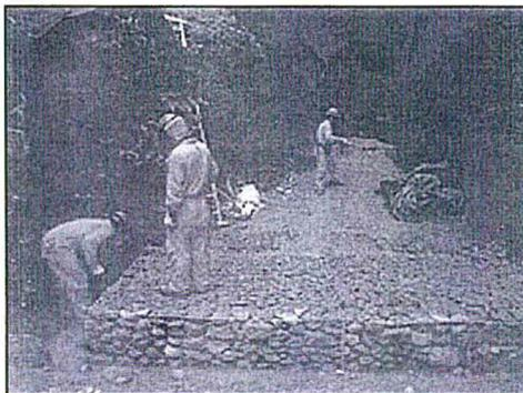
Registro fotográfico que evidencia la construcción de colchonetas reno en piedra en el talud del kp 41+550 (10 de octubre del 2017)
