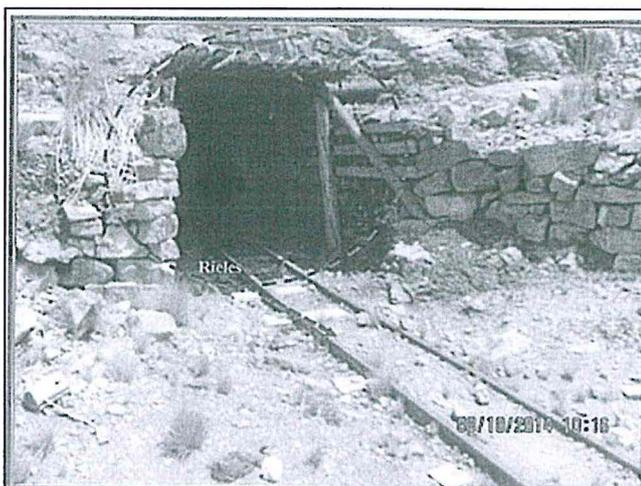
Fotografía N° 23: Hallazgo N° 1, Supervisión Regular octubre 2014, Se constató la galería subterránea (bocamina) en las coordenadas UTM (WGS 84) N: 8272614, E: 333244, no se observó trabajos de cierre y revegetación de dicha galería.
