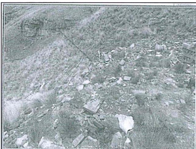
Fotografía N° 25: Hallazgo N° 1, Supervisión Regular octubre 2014, Vista del material de interior mina sobre el talud de suelo natural. Cabe mencionar que no se observó trabajos de cierre y revegetación de dicha galería.
