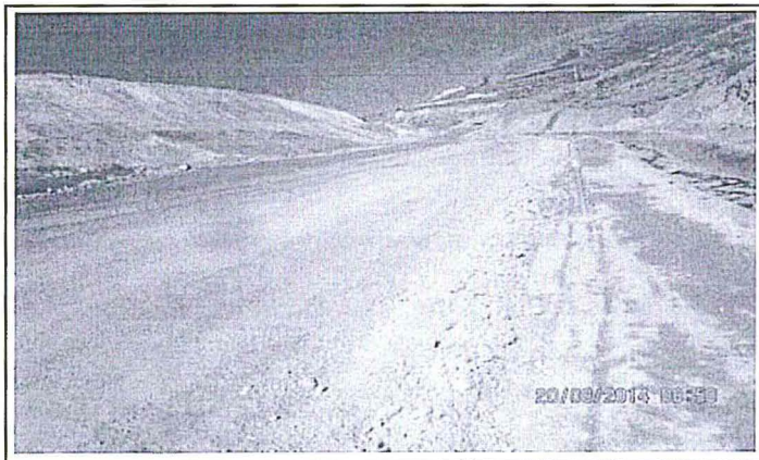
Foto 4. Acceso del depósito de desmonte No. 2. Colocación de berma para evitar el ingreso de agua de contacto a la cuneta del depósito de desmonte.
