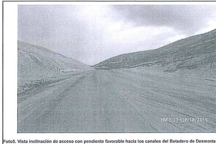
Foto5. Vista inclinación de acceso con pendiente favorable hacia los canales del Botadero de Desmonte 2
