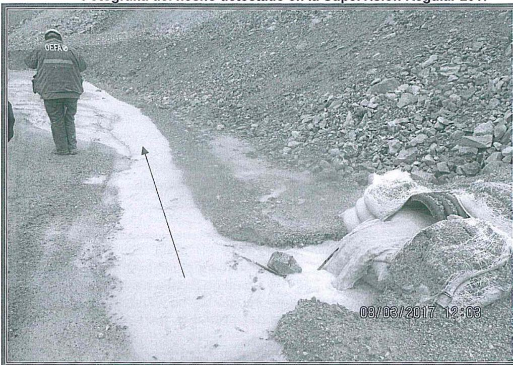
Fotografía N°59: Incumplimiento N°1, Tubería corrugada de 18" ubicada al pie del Botadero de Desmontes WRF en la coordenada referencial WGS 84 (201662 E, 8397557 N) la cual descarga aguas de contacto en dirección de la poza de contención WRF. Fuente: Panel fotográfico, anexo 2 del Informe de Supervisión Directa.
