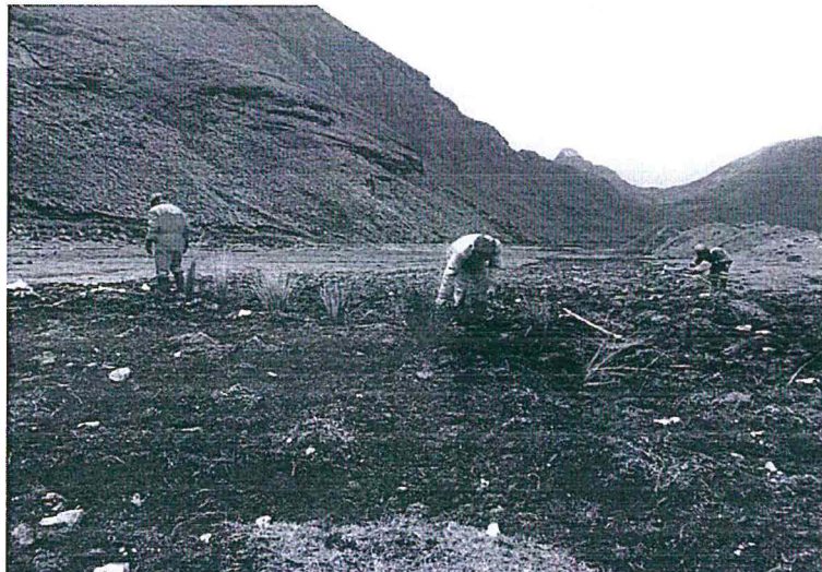
Colocación de stipa ichu para mejorar la revegetación existente Fuente: escrito de registro N.º 20053
