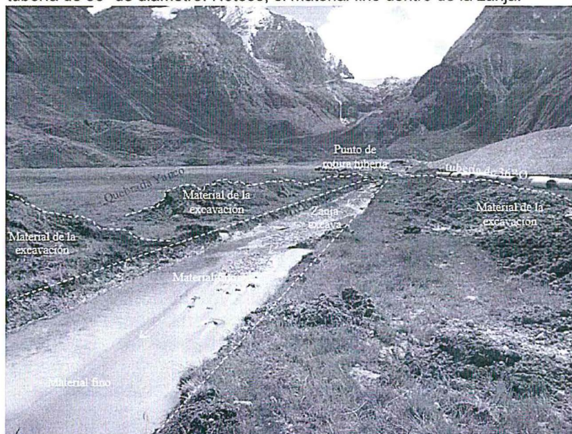
Fotografía N.º 4: Vista de la excavación de zanja para la instalación de la tubería de 36" de diámetro. Nótese, el material fino dentro de la zanja.
