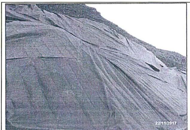
Fotografía N° 1.- Montículos de Material Top Soil y Material excedente de la Plataforma P4 (Coordenadas WGS84 = 0387754, 8698106) cubiertos con material impermeable.
