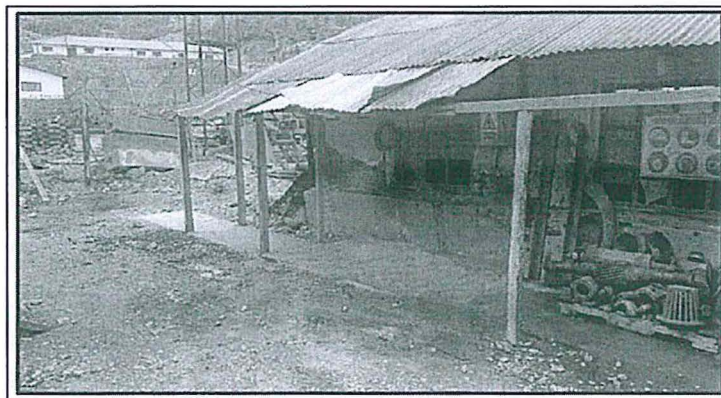
Fotografía: Limpieza y mantenimiento
