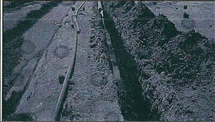
Foto N02: Se está realizando la excavación para el retiro de las tuberías de 4" para su posterior captación y derivación a la Planta de Tratamiento de Orcococha.
