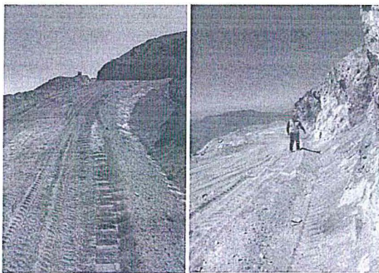
Fotografía N° 04 y 05: Habilidadación de cunetas en el Proyecto de Exploración Minero "Sanca".
