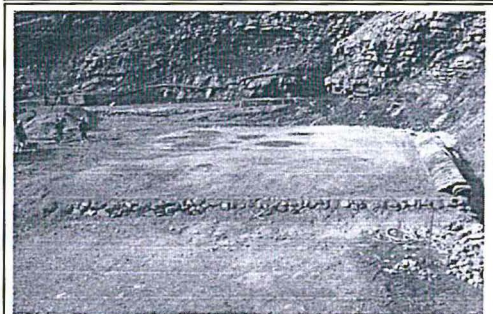
Fotografía N° 3. Vista fotográfica que muestra la delimitación de la Cancha provisional de Mineral, con la instalación de la geomembrana encima de material estéril y material estéril encima de la geomembrana.
