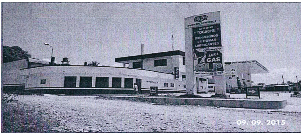
Fotografía N° 1: Vista Panorámica de la unidad fiscalizable Estación de Servicio con Gasocentro de GLP Grifo & Gasocentro Tocache S.A.C, ubicada en el Jr. Bolognesi C-1, distrito y provincia Tocache, departamento de San Martín.
