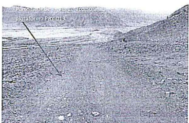
Fotografía N° 017: Parte final de la vía de acceso a plataforma de perforación PRY-013 con coordenadas 8 595 138 N; 329 540 E (Datum: WGS84; Zona: 18).
