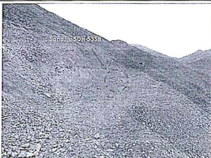
Fotografía N° 013: Plataforma de perforación PRY-013 correspondiente a sondajes SDH-5558 con coordenadas W 6594970; E 329598 (Datum: WGS84; Zona: 18).
