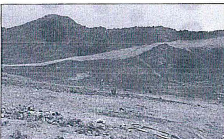
Foto N°8 - Cierre de acceso a la Plataforma 12 debidamente coberturada con material propio.
