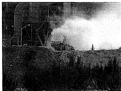
Foto N°42: Barredora industrial descargando residuos recogidos sobre terreno generando gran dispersión de material particulado.
