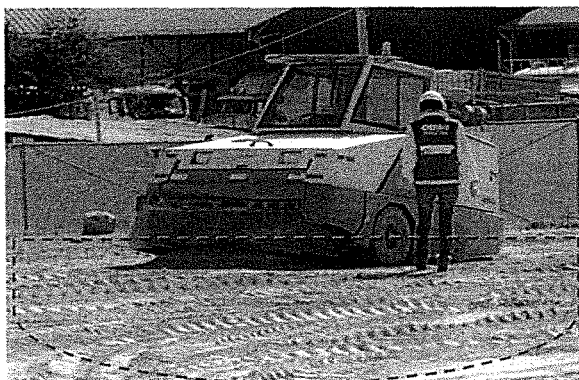
Foto N°43: Material particulado recogido por la barredora industrial dispuesto sobre el terreno del administrado.
