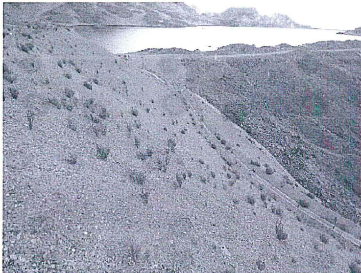
Fotografía N° 35: Vista fotográfica de la cancha de desmorte C-28A ubicada en las coordenadas geográficas UTM WGS84 N8426040, E357787. Formada por dos (2) banquetas. Area cubierta de material particulado compactado. Se observó la aparición de vegetación principalmente en los taludes.
