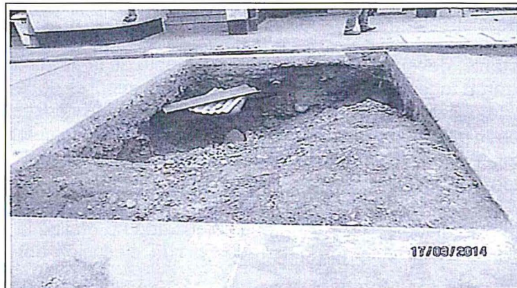
Imagen N° 3: Desmante en la fosa donde se encontraba el tanque
