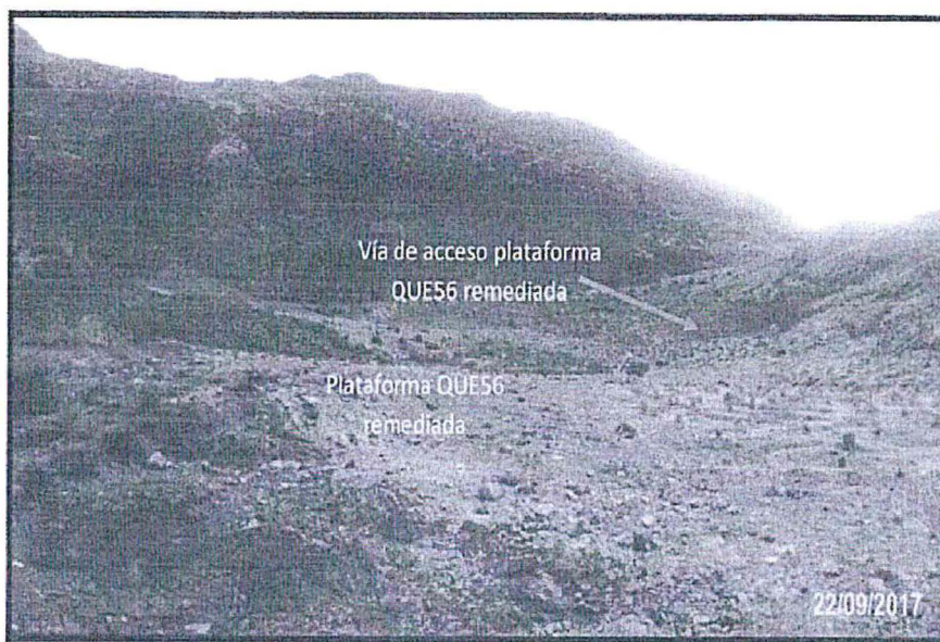
Fotografía N°2-2017. Muestra la plataforma y el acceso remediado QUE56.
