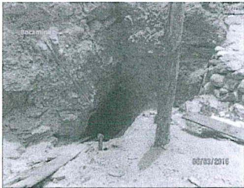
Fotografía N° 007: Se observó 3 bocaminas las cuales se encontraban en un área que presentaban corte en el terreno. (Coordenadas UTM WGS84 E 761 555; N 9 078 305)
