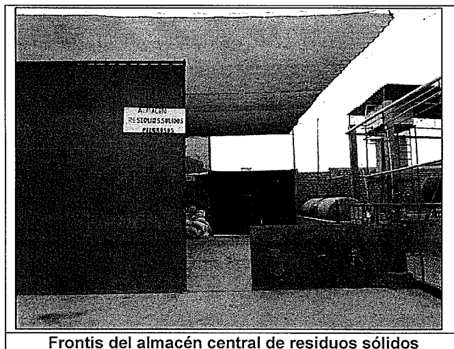
Frontis del almacén central de residuos sólidos
