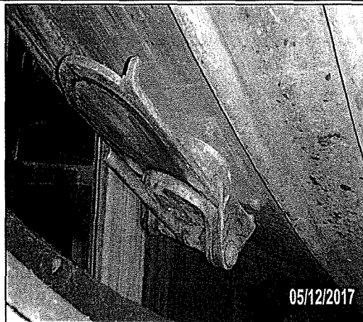
Vista de válvula de drenaje instalada en botal Coordenadas: 9104670 N, 715901 E (WGS 84, zona 17 L)
