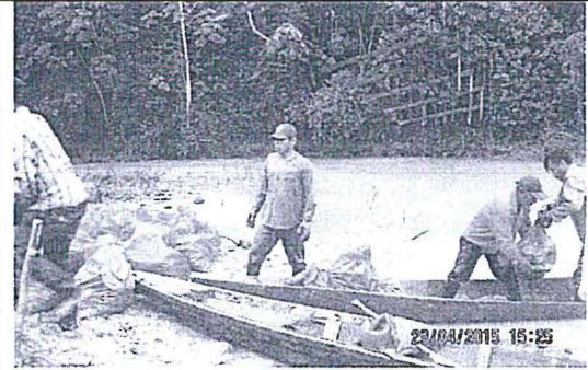
Fotografía N° 16. Descripción: Vista del traslado de los residuos obtenidos durante la limpieza de la Quebrada Yarina. Coordenada UTM: 9179829N – 506977E.
