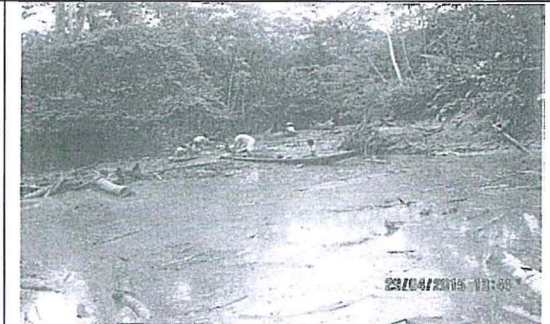
Fotografía N° 8. Descripción: Vista de las actividades de recuperación del hidrocarburo y vegetación impregnada con crudo. Actividad desarrollada por el personal de la comunidad. El producto es retenido mediante barreras de troncos y palos. Coordenada UTM: 9179871N-507921E. EL punto observado es en la Quebrada Yarina.
