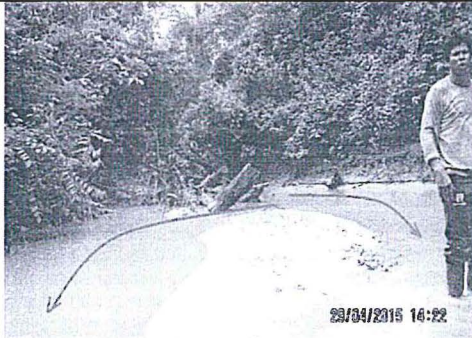
Fotografía N° 15. Descripción: Vista del Punto de la Quebrada Yarina donde ya no se puede surcar aguas arriba (imposibilitando la inspección).
