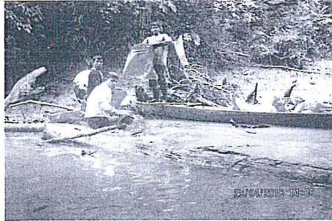
Fotografía N° 13. Descripción: Vista de las actividades de recuperación del hidrocarburo y vegetación impregnada con crudo. Actividad desarrollada por el personal de la comunidad. El producto es retenido mediante barreras de troncos y palos. Coordenada UTM: 9179871N-507921E. EL punto observado es en la Quebrada Yarina.
