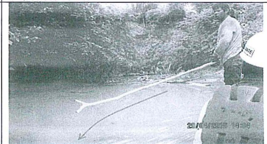
Fotografía N° 12. Descripción: Vista de las actividades de recuperación del hidrocarburo y vegetación impregnada con crudo. Actividad desarrollada por el personal de la comunidad. EL producto es retenido mediante barreras de troncos y palos. Coordenada UTM: 9179871N-507921E. EL punto observado es en la Quebrada Yarina.
