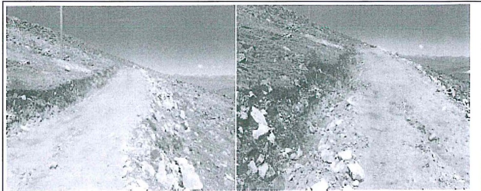
FOTO N°11 y 12: Vista de cunetas en el acceso a la plataforma de perforación N°23 remediada.
