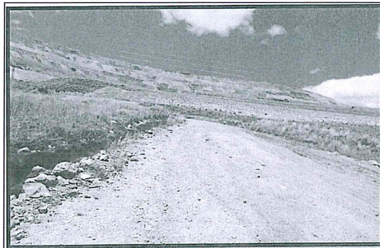
Fotografía N° 1: Sistema de cunetas a lo largo de las pozas existentes Fuente: Minera Barrick Misquichilca S.A.
