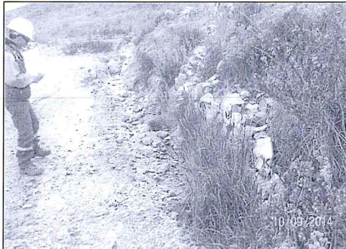
Fotografía N° 192: Hallazgo N° 4, En un tramo de la vía de acceso al Botadero de Desmonte Este, en las coordenadas UTM Datum WGS84: 9121148 N y 0804720 E, se evidencio el afloramiento de aguas de filtración de coloración rojiza, al pie del talud de la vía de acceso la misma que discurría sobre el suelo sin impermeabilizar.
