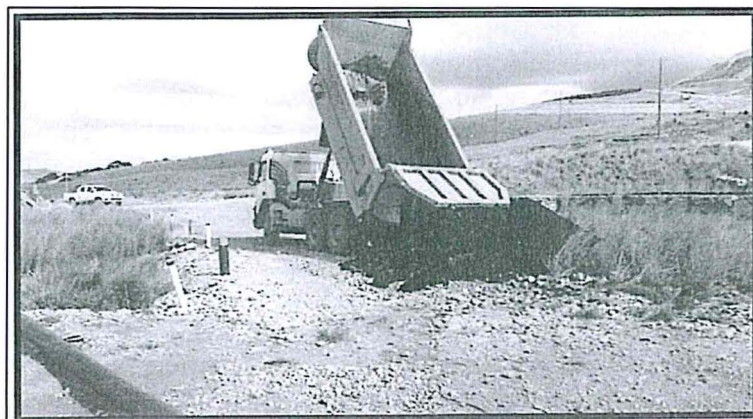
Fotografía N° 5: Disposición de top soil en zona impactada Fuente: Minera Barrick Misquichilca S.A.
