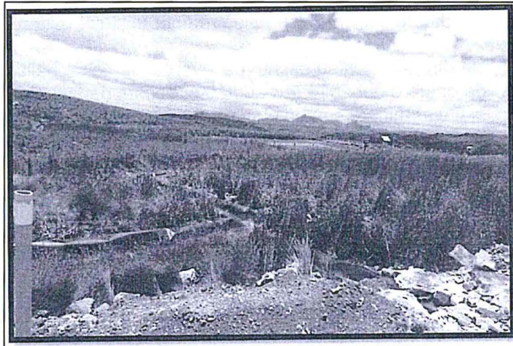
Fotografía N° 3: Sistema de cunetas a lo largo de las pozas existentes Fuente: Minera Barrick Misquichilca S.A.
