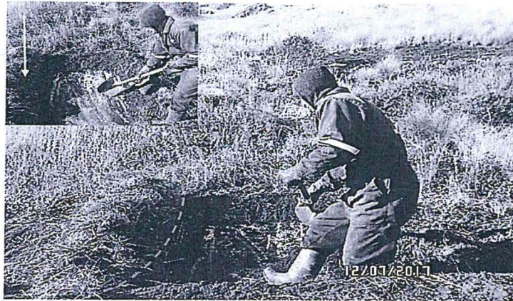
FOTO N° 8: Retiro de parte de cobertura para el monitoreo del tapón construido en el componente BLO-140A (sector Lola Atahualpa)
