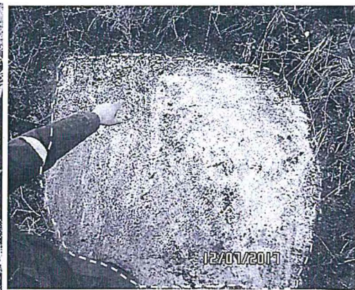
FOTO N° 10: Verificación reciente (julio 2017) del estado del tapón de concreto (hermético) Tipo III construido en marzo 2015 sobre el componente BLO-140A (sector Lola Atahualpa) (no informado al OEFA)
