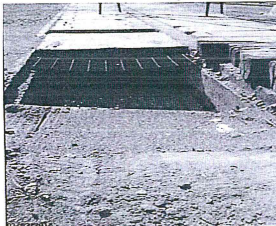
Foto N° 6: Canal de captación
