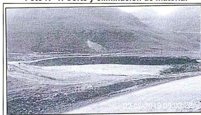
Foto N° 1: Corte y eliminación de material
