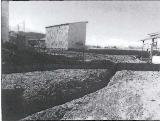
Fotografía N° 12: Preparación del canal de coronación (sin geomembrana).
