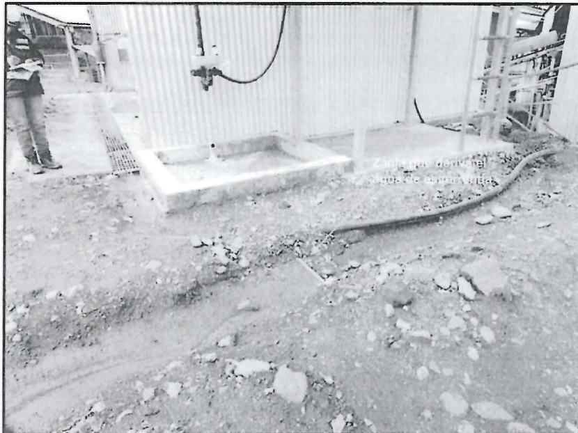
Fotografía N°15: Vista fotográfica de donde se aprecia una zanja que deriva el agua de escorrentía de la planta concentradora.
