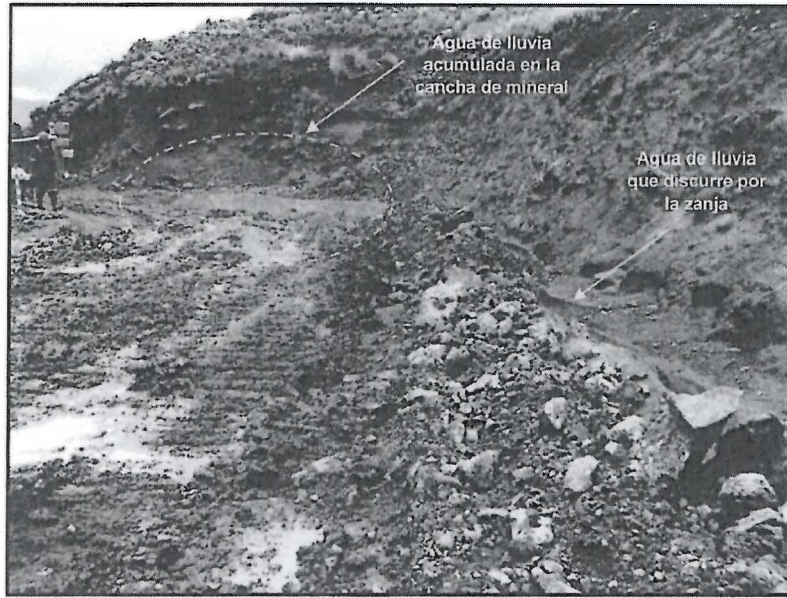
Fotografía N°09: Vista fotográfica donde se aprecia la cancha de mineral de baja ley, aquí se observa una zanja al lado de la cancha por donde discurre el agua de esorrentía.
