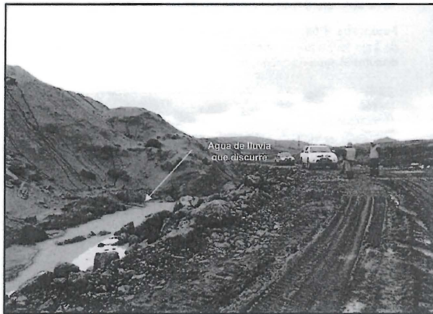
Fotografía N°13: Vista fotográfica del desmonte lado oeste donde se aprecia como discurre el agua de escorrentía, generando la erosión del suelo.
