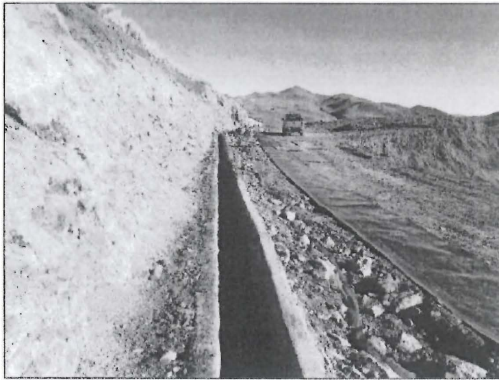
Fotografía N° 8: Labores de preparación del canal de coronación.
