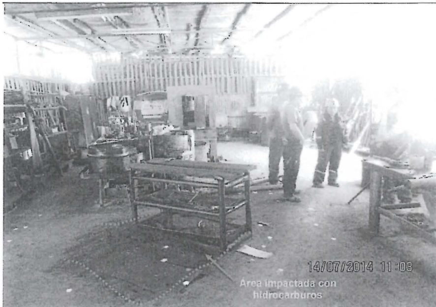
Fotografía N° 83: Hallazgo N° 8, supervisión julio 2014, En el Taller de maestranza y Taller de soldadura mina, se observó que este no cuenta con piso y por el contrario esta sobre suelo natural donde existe suelo impactado con hidrocarburo (N: 8240418, E: 0708541).
