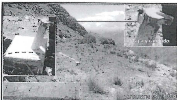
Fotografía N° 46: HALLAZGO 04: Vista panorámica del sondaje GTA-03-12. Se puede apreciar la tapa de hierro y el candado, además la palabra "Piezómetro" en el dado de concreto. Coordenadas de ubicación (Datum WGS 84 - Zona 19): E 186491, N 8453648.
