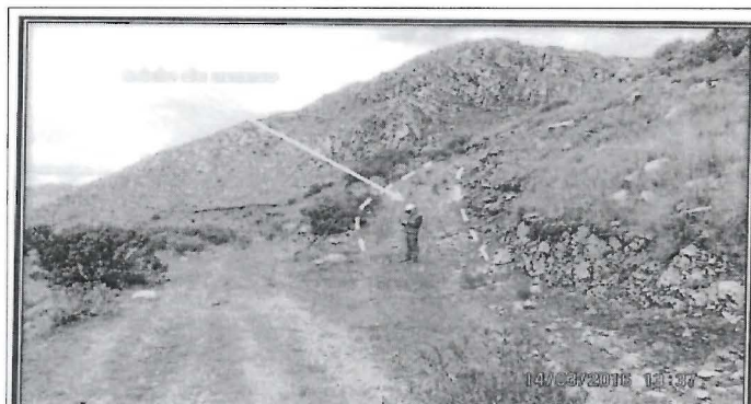
Fotografía N° 45: HALLAZGO 03: Vista del acceso a la plataforma donde se ejecutó el sondaje GTA-03-12. Coordenadas de ubicación (Datum WGS 84 - Zona 19): E 186462, N 8453738.
