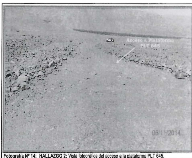
Fotografía N° 14: HALLAZGO 2: Vista fotográfica del acceso a la plataforma PLT 645.
