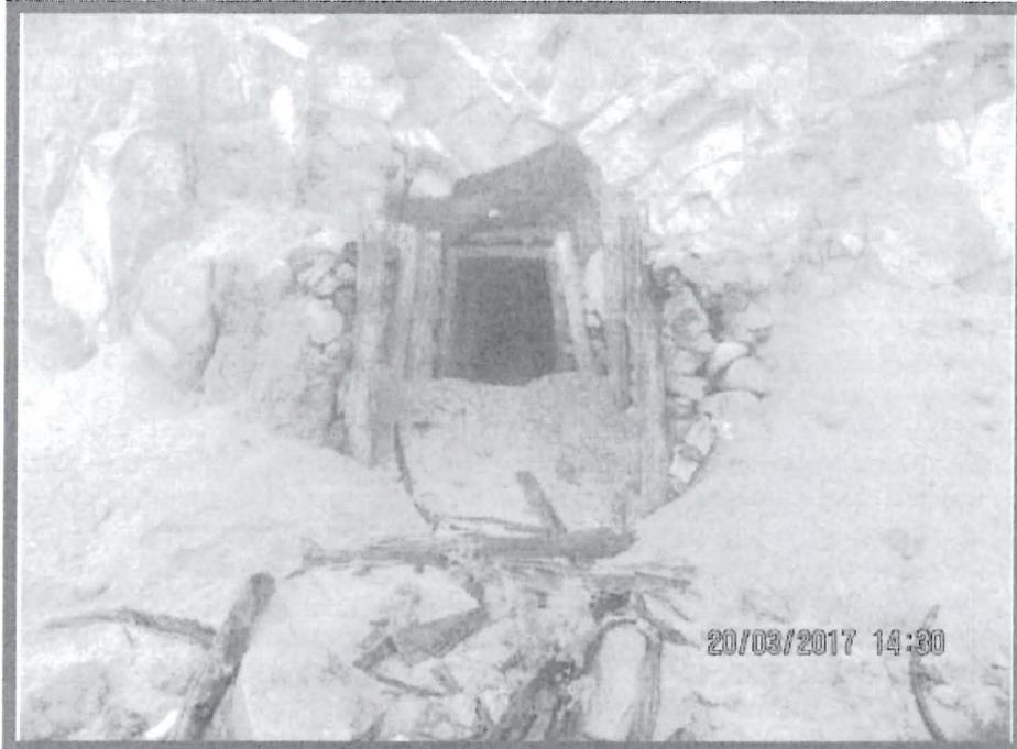
**Fotografía N° 20:** Se observó el pasivo N° 13. Se encontró abierta la entrada a la labor, se observó varios montículos de tierra y 6 postes de madera puestos en forma vertical. El sostenimiento en la entrada cuenta con postes y encribado de madera. No se observó drenaje.
