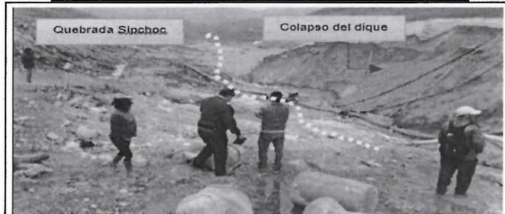
Vista fotográfica N° 2: Del discurrir del agua decantada y de relave fino proveniente del colapso del dique correspondiente al depósito de relaves N° 2 hacia la quebrada Sipchoc.
