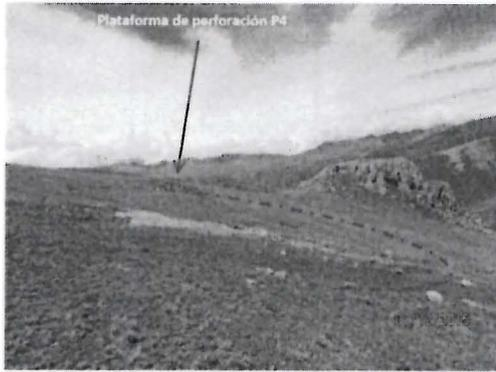
Fotografía N° 023: El área de la plataforma de perforación P4 se encontraba perfilada y sin revegetar. Asimismo, con presencia de rocas sueltas. (Coordenadas UTM WGS84: E 408 850; N 8 396 631)
