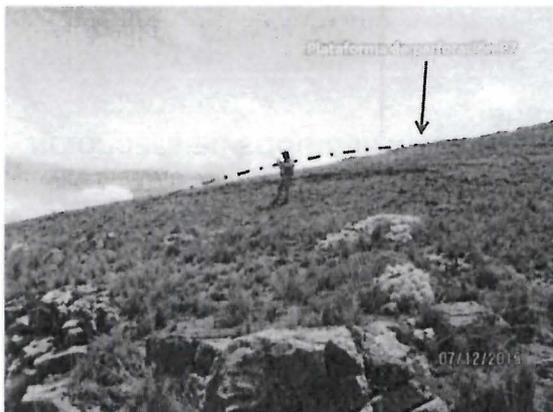
Fotografía N° 001: En la plataforma de perforación P7 se observó que el área se encontraba perfilada y sin revegetar. (Coordenadas UTM WGS84 E 408 827, N 8 397 103).
