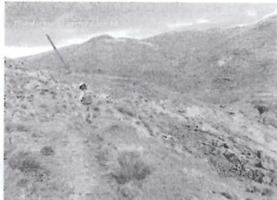
Fotografía N° 051: El área de la plataforma de perforación P2 presenta corte en el talud, asimismo, no se encontraba perfilada, ni revegetada (Coordenadas UTM WGS84: E 408 834; N 8 396 601)
