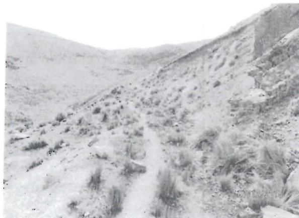
Fotografía N° 052: La vía de acceso a la plataforma de perforación P2 se encontraba sin perfilar y sin revegetar. Asimismo presentaba rocas sueltas (Coordenadas UTM WGS84: E 408 776; N 8 396 619).
