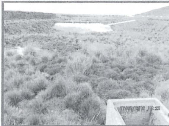
**Fotografía N° 129:** Manejo del agua residual doméstica tratada proveniente del campamento Colquijirca: Vista de la laguna facultativa N° 2 (Poza de oxidación N° 2), ubicado adyacente al punto de coordenadas UTM WGS 84: 362104E y 8809653N, (hallazgo 6).
