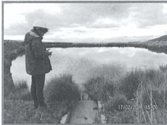
**Fotografía N° 128:** Manejo del agua residual doméstica tratada proveniente del campamento Colquijirca: Vista de la laguna facultativa N° 1 (Poza de oxidación N° 1), ubicado adyacente al punto de coordenadas UTM WGS 84: 362061E y 8809734N, (hallazgo 6).
