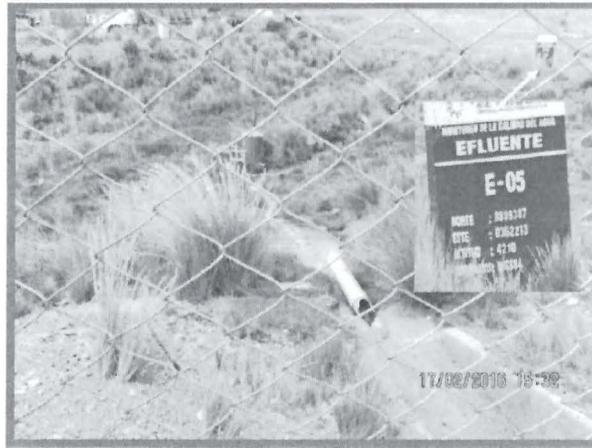
Fotografía N° 132: Manejo del agua residual doméstica tratada proveniente del campamento Colquijirca. Vista de la descarga al curso natural de agua de la denominada quebrada Unish, del agua residual doméstica tratada proveniente del campamento y población de Colquijirca, (hallazgo 6).
