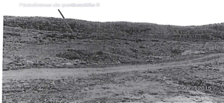
Fotografía N° 018: El área de la plataforma de perforación 9 se encontraba sin perfilar y sin revegetar, asimismo, se observó rocas sueltas (Coordenadas UTM WGS84: E 375 651; N 8 393 455).
