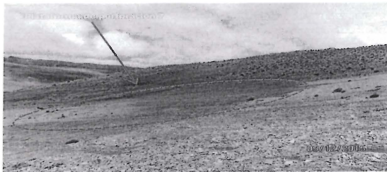
Fotografía N° 020: El área de la plataforma de perforación 7 se encontraba perfilada y sin revegetar. (Coordenadas UTM WGS84: E 375 473; N 8 394 473).
