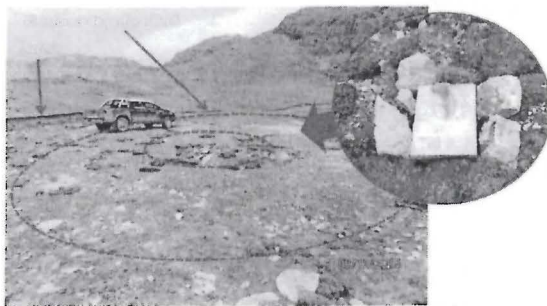
Fotografía N° 044: El área de la plataforma de perforación 8 se encontraba perfilada y sin revegetar, asimismo se observó 1 sonda en un bloque de concreto con una tubería de PVC. (Coordenadas UTM WGS84: E 375 529, N 8 393 944)
