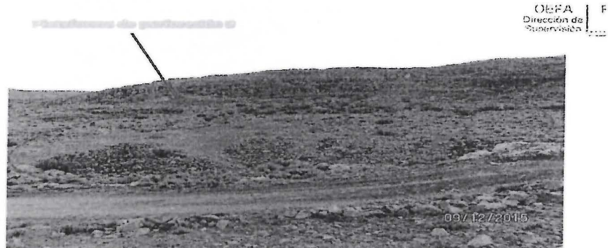
Fotografía N° 017: El área de la plataforma de perforación 9 se encontraba sin perfilar y sin revegetar, asimismo, se observó rocas sueltas (Coordenadas UTM WGS84: E 375 651; N 8 393 455).
