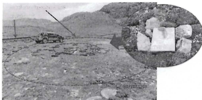
Fotografía N° 044: El área de la plataforma de perforación 8 se encontraba perfilada y sin revegetar, además se observó 1 sondaje en un bloque de concreto con una tubería de PVC (Coordenadas UTM WGS84: E 375 529; N 8 393 944).
