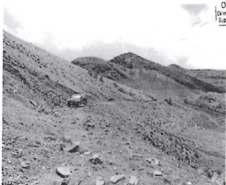
Fotografía N° 023: La vía de acceso a la plataforma de perforación 7 se encontraba sin perfilar, asimismo, se observó rocas sueltas y deslizamiento de material proveniente del corte del talud. (Coordenadas UTM WGS84: E 375 577, N 8 394 258)
