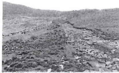
Fotografía N° 076: La vía de acceso a las plataformas 13 y 14 se encuentra en perfecto estado, presentando rocas sueltas y sin vegetar en algunos tramos (Coordenadas UTM WGS84: E 376 543; N 392 602).
