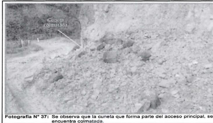
Fotografía N° 37: Se observa que la cuneta que forma parte del acceso principal, se encuentra colmatada.
