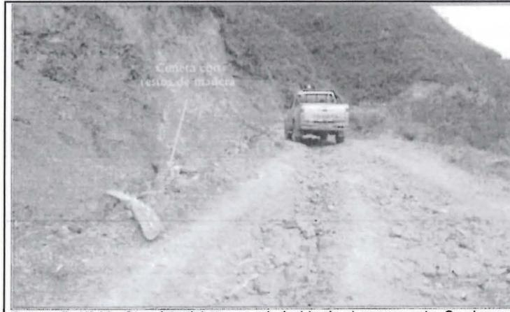
Fotografía N° 36: Otra vista del acceso principal hacia el campamento. Se observa restos de madera en la cuneta y la erosión de los suelos.
