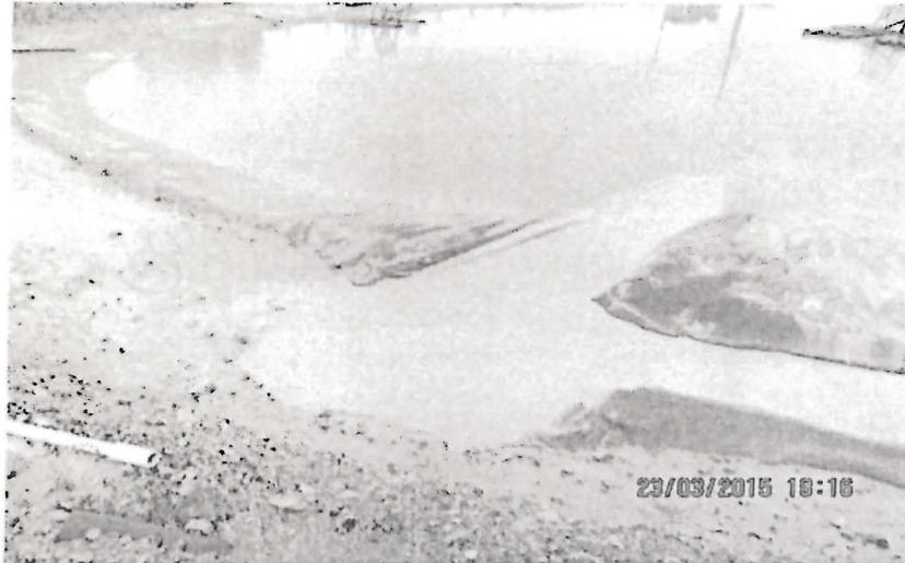
Foto N° 10: Poza de sedimentación N° 3, se observa el agua ingresando a la misma por un extremo debido a que sobrepasó su capacidad de carga.
