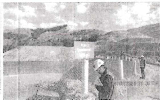
Fotografía N° 12 Pozas de Sedimentación (Pucaurán) - Se observa la Poza N° 3 la cual cumple la función de sedimentación y clarificación final de las aguas acidas subterráneas de las pozas de escurrimientos del tajo abierto, y este poza cuenta con revestimiento de geomembrana y cerco perimetrico. De esta poza se plumbotan el agua a ser tratada en la Planta ARD 450. Su capacidad es de 9 000 m<sup>3</sup>.
