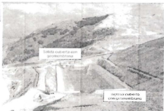
Fotografía N° 8 Poza PCN 1. Ubicada en las coordenadas Datum WGS84 Zona 18: 216047E, 8872365N. Poza excavada en suelo con revestimiento pario de geomembrana en las estructuras de ingreso y salidas y ubicada en el sector norte del tajo. Se utilizó para la sedimentación de las aguas de escorrentías del sector norte del tajo. Su capacidad es de 27 000 m<sup>3</sup>.
