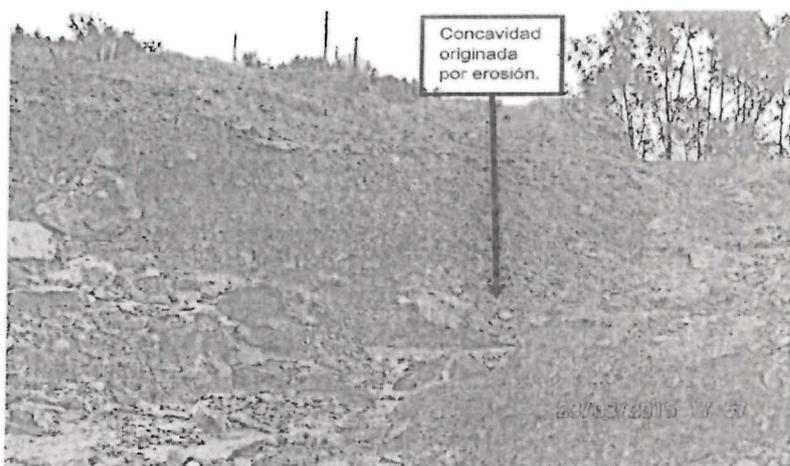
Foto N° 4: Vista ampliada de la concavidad originada, producto de las intensas lluvias, a un costado del alcantarillado de entrada a la poza de sedimentación N° 1.
