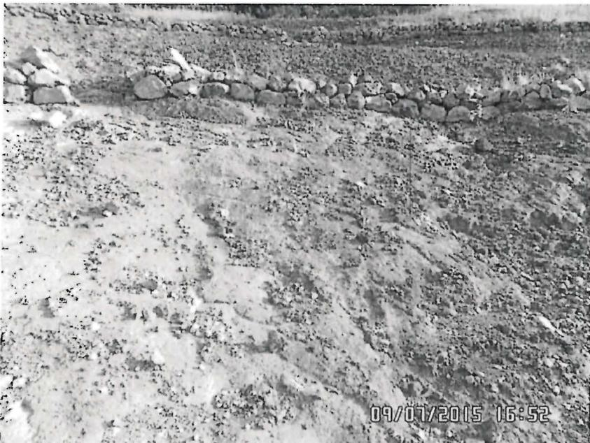
Fotografía N° 129: Hallazgo N° 1: Sector Quebrada Honda, otra vista de un sector del depósito de desmontes con código de identificación DDBQH-4 ubicado en las coordenadas UTM WGS84 N-9251476, E-765516. Donde se observó que se encuentra sin revegetación completa.
